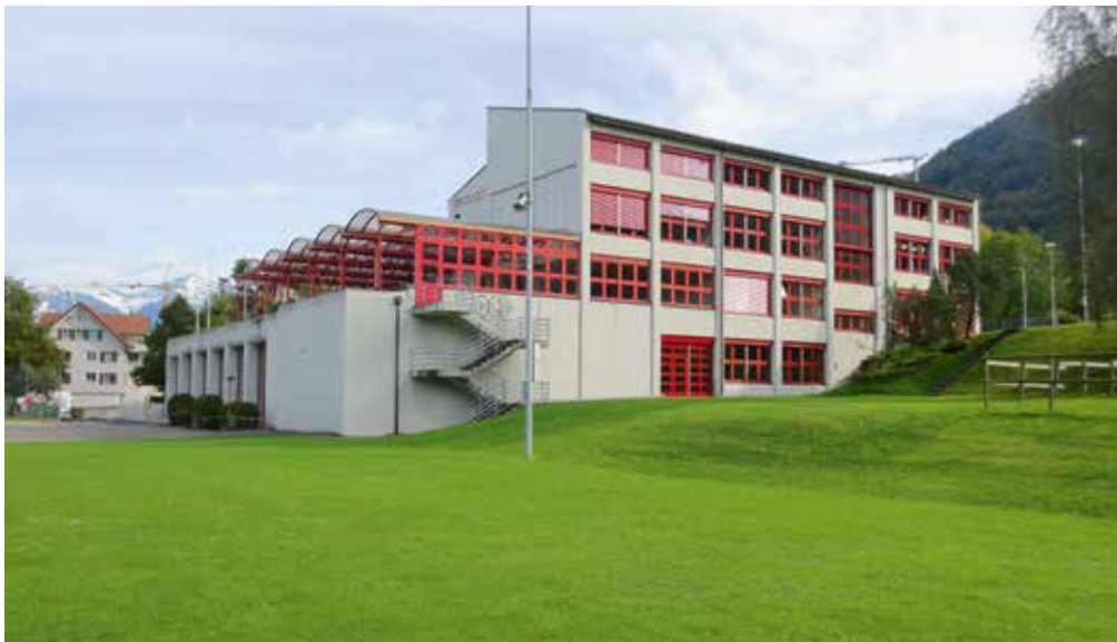
Die Mehrzweckhalle «Gutenbrunnen» in Schübelbach, Tagungsort 2025.
