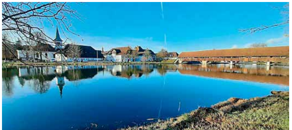
Pont de bois avec caserne, saline et église.
